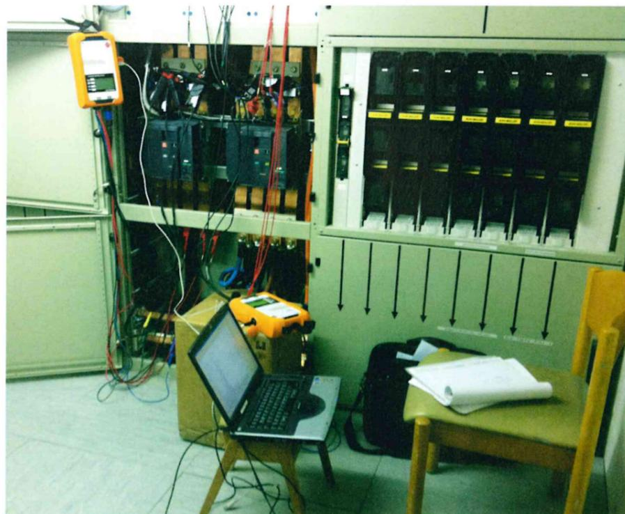
Bild 5. Messaufbau zur Aufzeichnung der OS-Lastungen an der Niederspannungshauptverteilung für die Sicherheitsstromversorgung im Netz- und Notstrominselbetrieb
